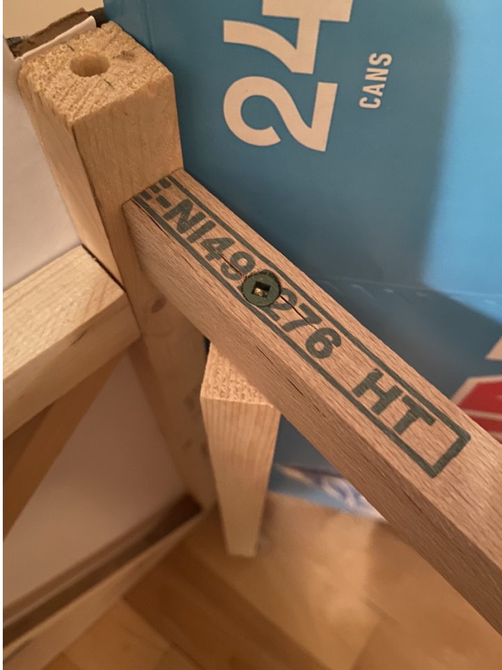
Figure 5 : Vis de 1"1/4 visser dans le bois de construction
