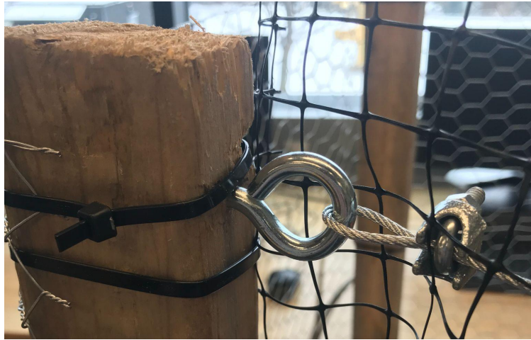
Figure 16 : Installation des anneaux
