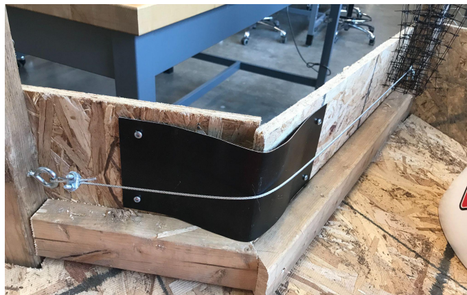
Figure 18 : Installation du câble inférieur et installation de feuille de tôle
