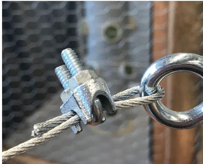
Figure 17 : Attache des câbles
