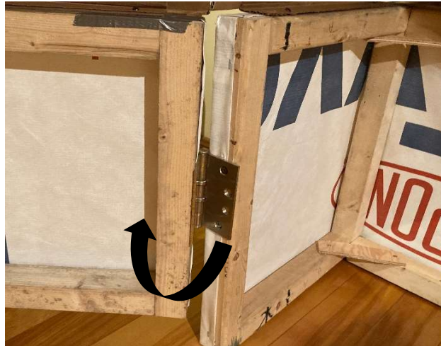
Figure 9. Mécanisme de charnière
