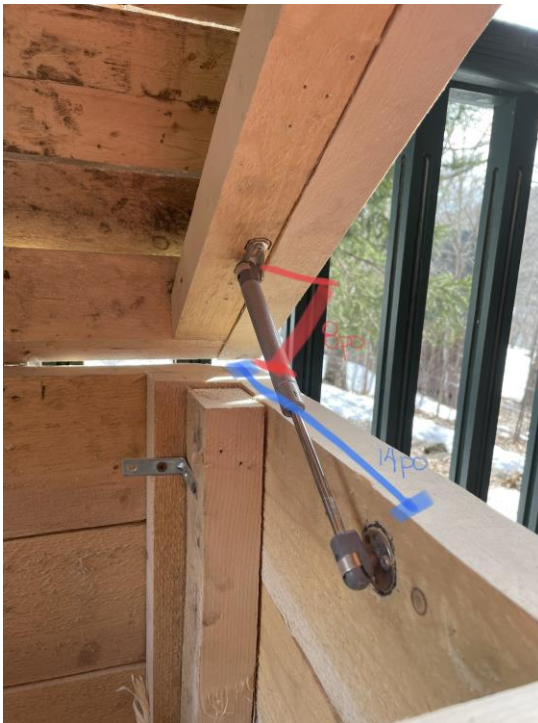
Figure 31. Vue du piston et les dimensions pour l'installer
