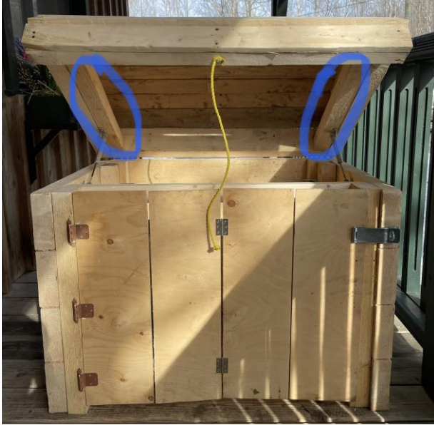
Figure 28. Couvercle vue de dessous, bois pour solidifier
