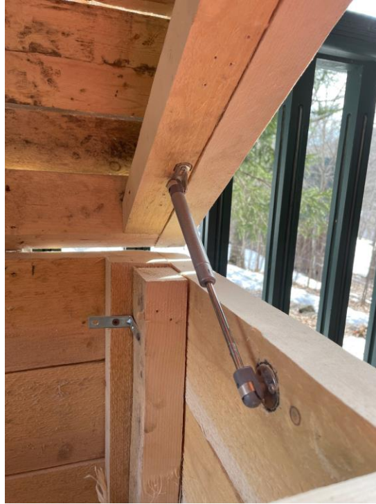
Figure 20 : Le piston qui supporte le couvercle
