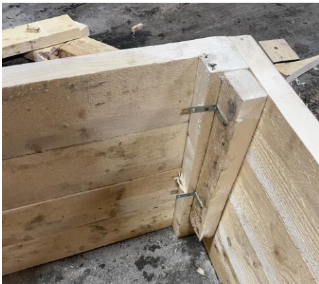
Figure 22. Vue sur les équerres pour fixer les murs ensemble
