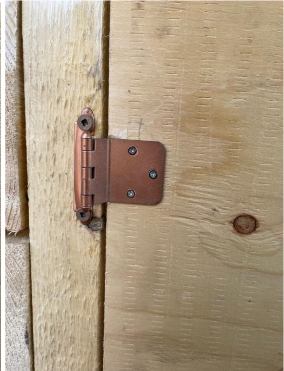
Figure 17 : Charnière qui tient la porte d'accordéon
