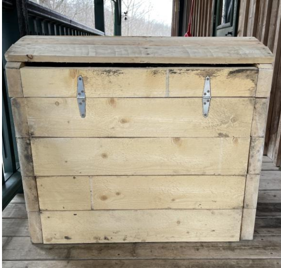
Figure 30. Vue de derrière du CP montrant les pentures en T
