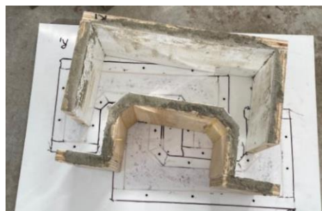
Figure 17 - Coffrage après le processus de décoffrage
