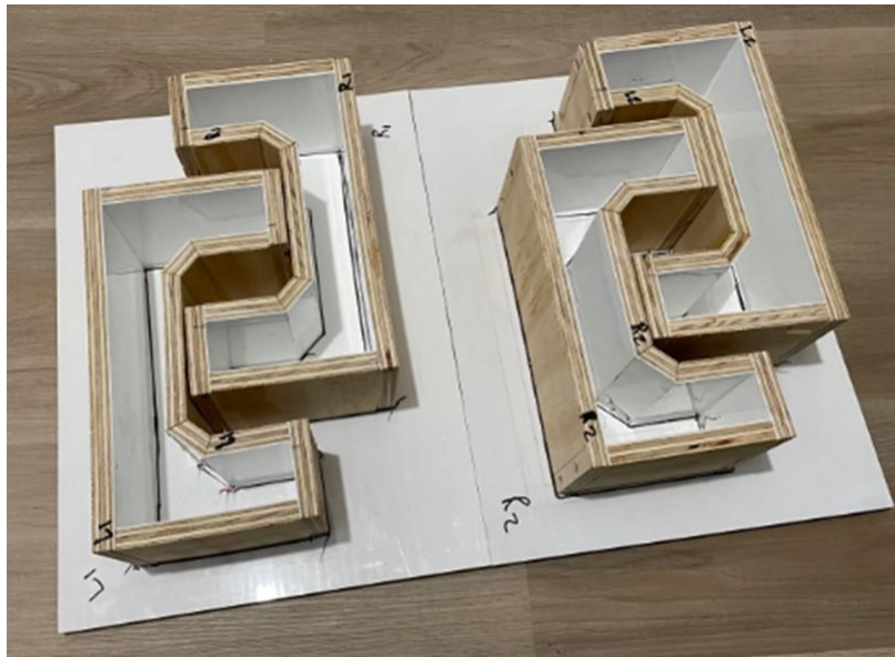
Figure 14 - Coffrage finalisé
